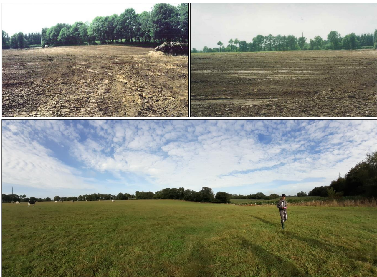
Figure RNT-4 : Environnement des travaux miniers sur le site de Keryacunff (à l'issue des travaux de remblaiement en 1993 (en haut) et en 2020 (en bas))
