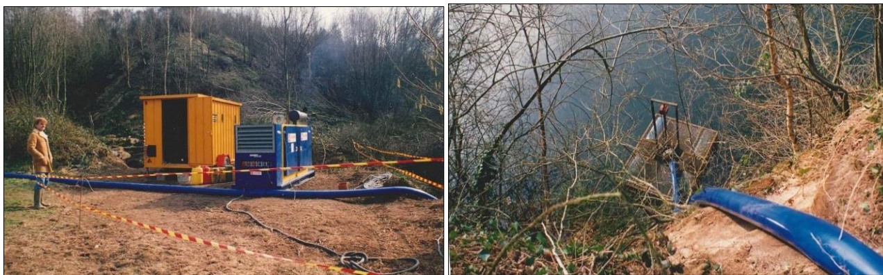
Figure 2-12 : Planches photographiques montrant le système de vidange (pompes immergées avec flotteurs) utilisé pour pomper les eaux de la MCO de Keryacunff (prises de vue, 1992, source ORANO)
