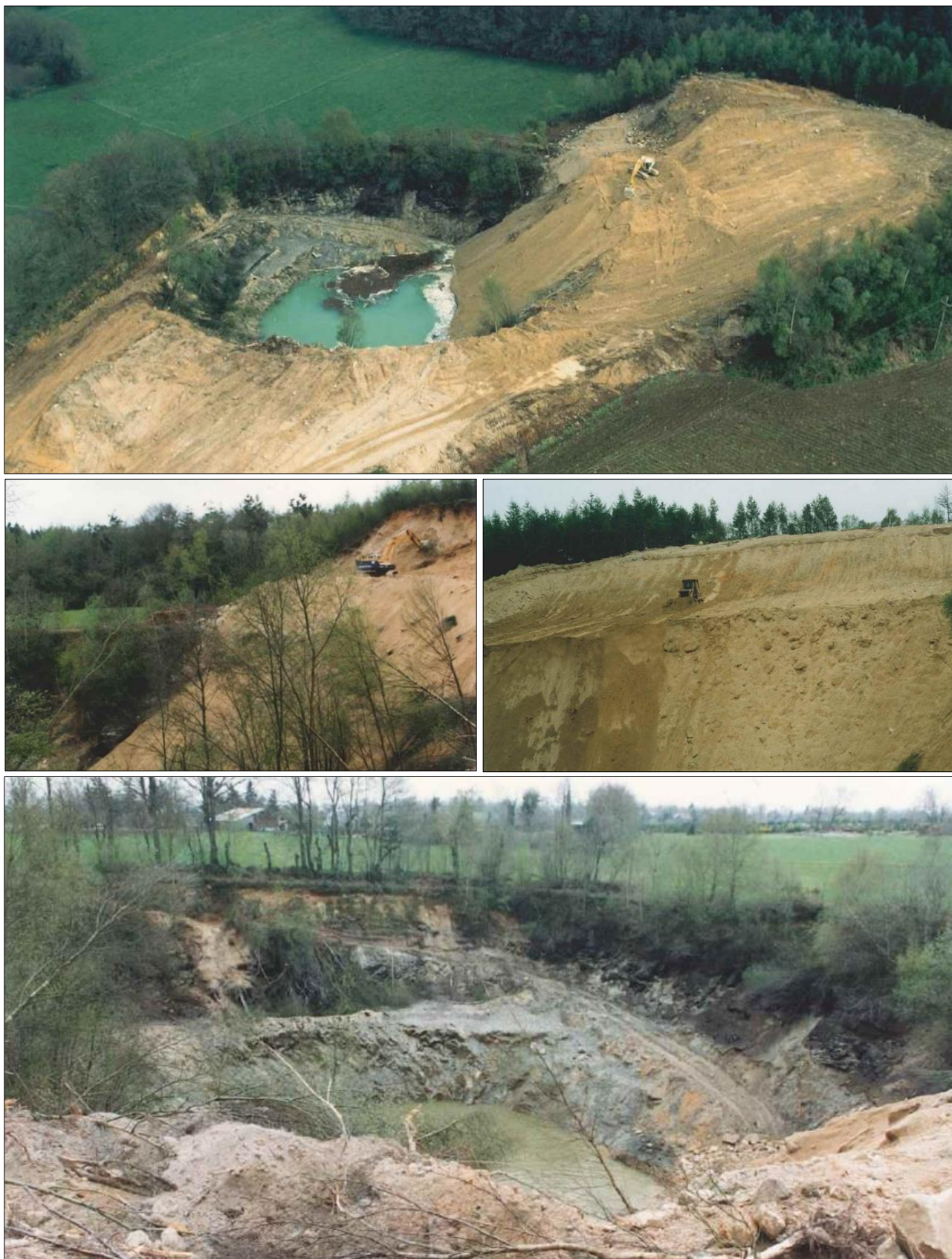
Figure 2-14 : Planches photographiques du remblaiement de la MCO (prises de vue, 1992-93, source ORANO)
