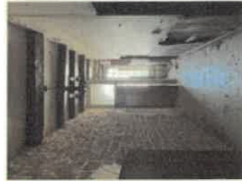
Circulation en bon état
