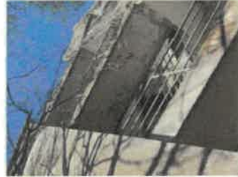
Escalier béton et ascenseur extérieur
