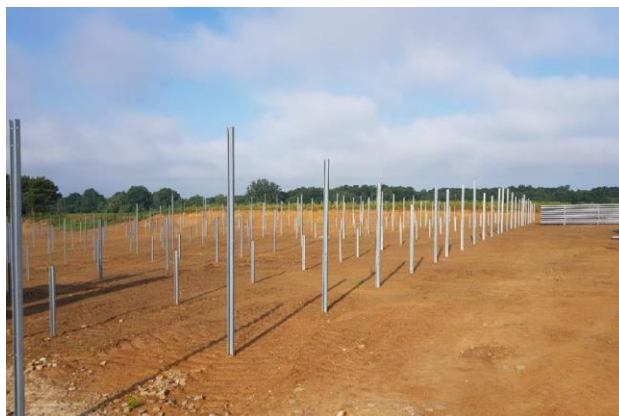
Figure 2 : Mise en place des pieux sur le chantier de Sablières de la Prée – CR de chantier de mai 2021
