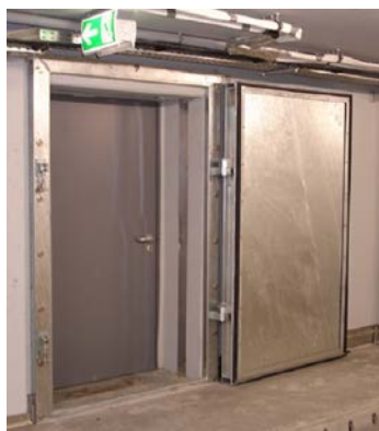
Figure 1 : Porte à fermeture simple
