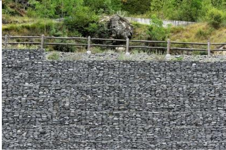
Gabions avec pierres appareillées
