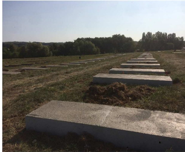
Exemple de mise en place de longrine - (Source : ENGIE Green)
