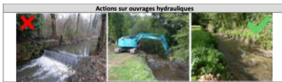
Exemple de travaux sur des ouvrages hydroliques
