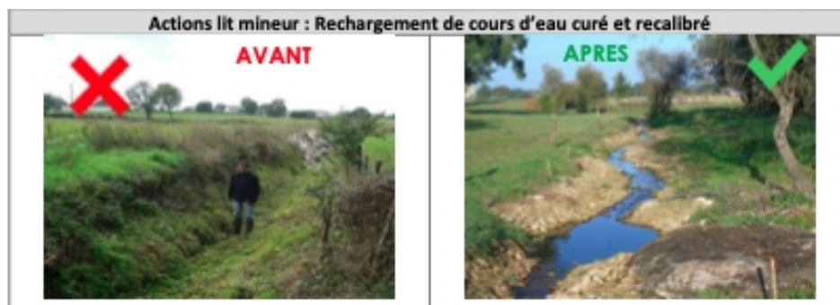
exemple de travaux lit mineure
