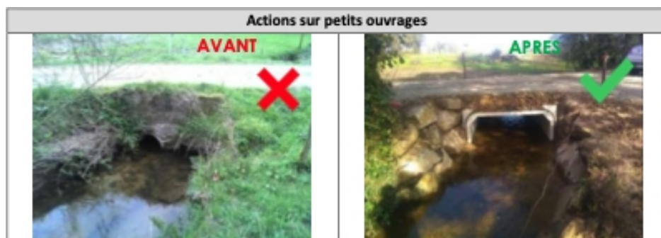
Exemple de travaux sur sur petit ouvrage
