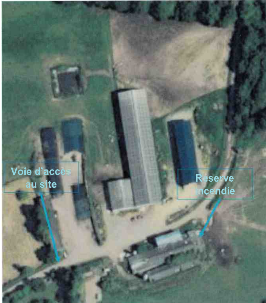
Vue aérienne du site de Tréfrain - Source : Géoportail
