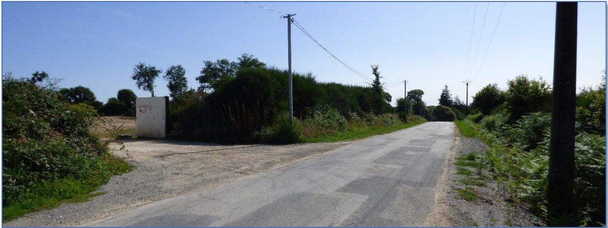
Fig. 18 : Vue n°4 : vue sur l'accès depuis l'ouest
