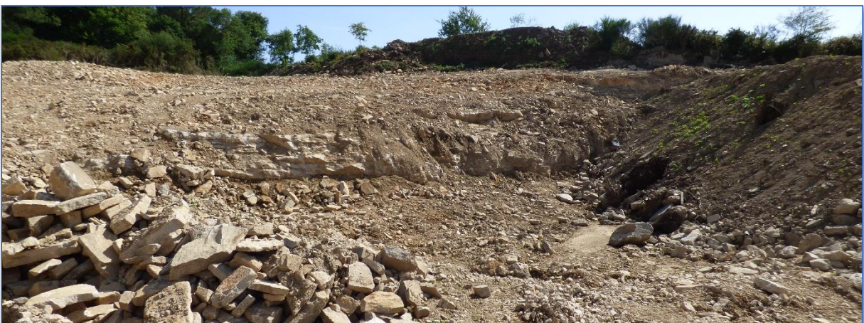
Fig. 23 : Vue n°9 : fond de l'excavation résiduelle
