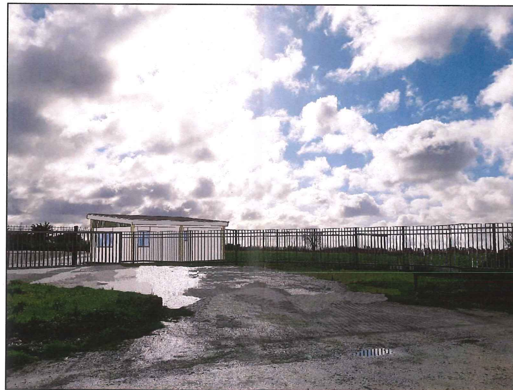
IMAGE D'INSERTION APRES TRAVAUX
