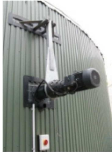
**Photo 6 : accessibilité par l'extérieur de l'agitateur à pale**
