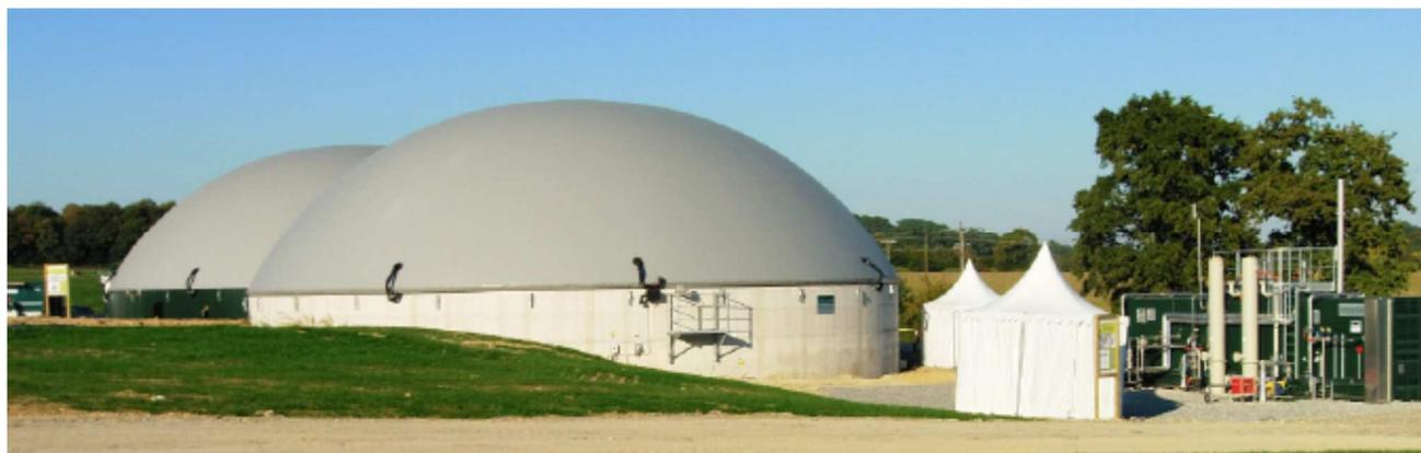
**Photo 8 : exemple de fermenteur et de post-fermenteur**
