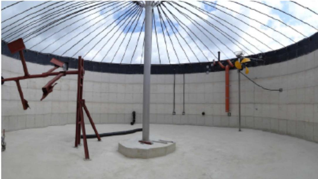
**Photo 4 : Exemple de digesteur béton en cours de construction**
