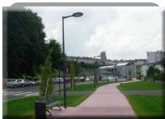
Le cheminement est parfaitement libre de tout obstacle
