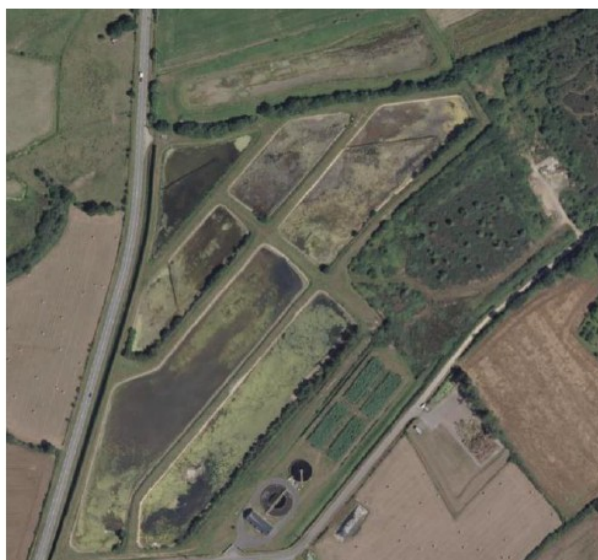
Vue aérienne de la station d'épuration et des lagunes (source étude d'impact)
