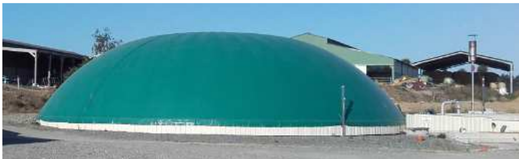
Vue actuelle du digesteur (à droite, enterré sous dalle béton) et du post-digesteur (avec gazomètre vert) du GAEC des Fiches
