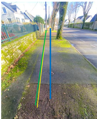
Reseaux eaux/gaz coté trottoir
