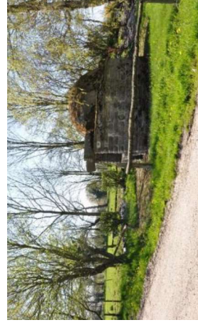
Photo 75 - Ancien four à pain bien conservé et mis en valeur en bord de route
