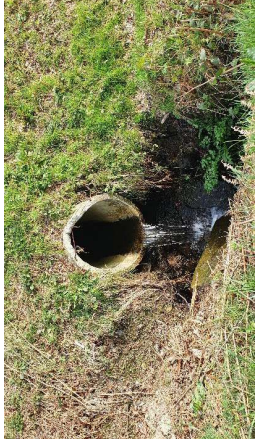
Photo 155- Rupture de discontinuité amont
