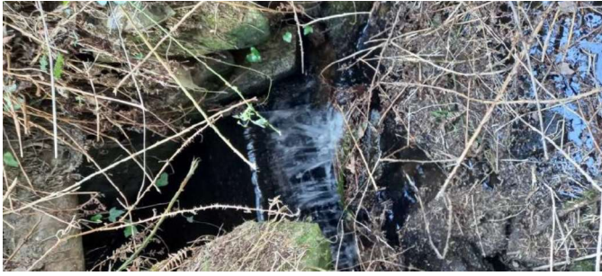
Photo 138- Discontinuité en aval de la route communale (source : Fédération de pêche 56)
