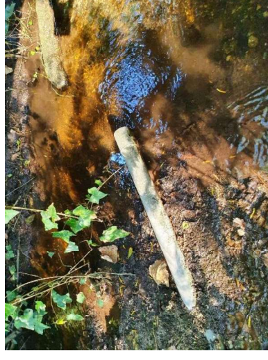
Photo 144- Exutoire du drain (tuyau PVC) directement dans le cours d'eau
