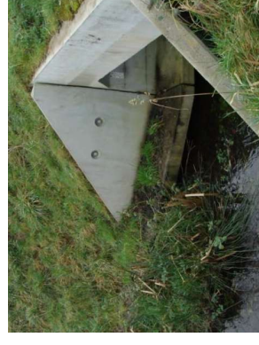
Figure 102- Exemple d'ouvrages de franchissement hydraulique avec banquette faune réalisés à Muzillac (source : CD 56)
