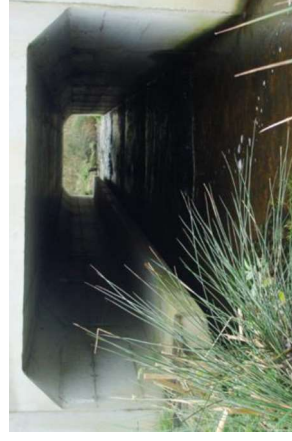
Figure 102- Exemple d'ouvrages de franchissement hydraulique avec banquette faune réalisés à Muzillac (source : CD 56)
