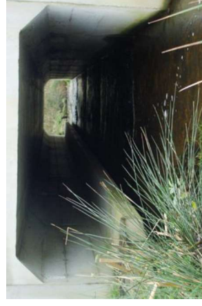
Photo 75- Exemple d'ouvrage de franchissement hydraulique avec banquette faune réalisée à Muzillac (source : CD 56)
