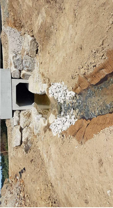
Photo 78- Exemple d'aménagement seuil de contrôle en aval de l'ouvrage (Giratoire de Pont Hamon – Reguiny, source : CD 56 – AMO Synergis Environnement)
