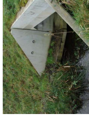
Photo 75- Exemple d'ouvrage de franchissement hydraulique avec banquette faune réalisée à Muzillac (source : CD 56)
