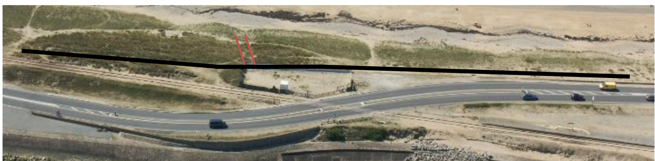
Photo 22 : Secteur de canalisation vers la plage dans le deuxième secteur au nord du Fort de Penthièvre (avant et après les travaux) (photo : Auteurs de vues)
