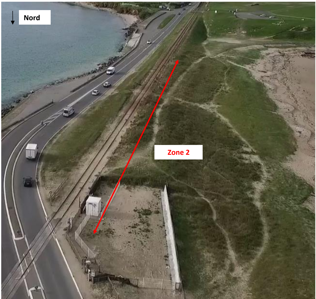
Photo 7 : Localisation de la zone 2 (photo : Auteurs de vues)
