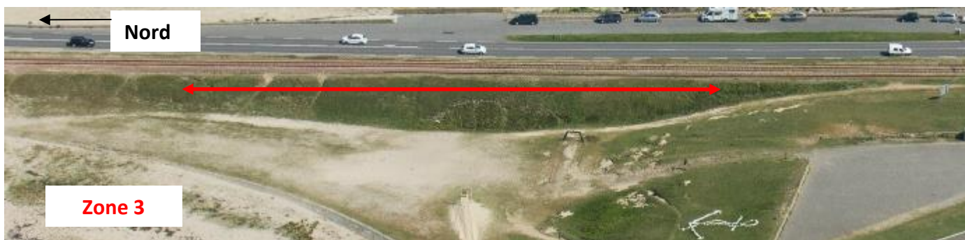
Photo 8 : Localisation de la zone 3 (photo : Auteurs de vues)
