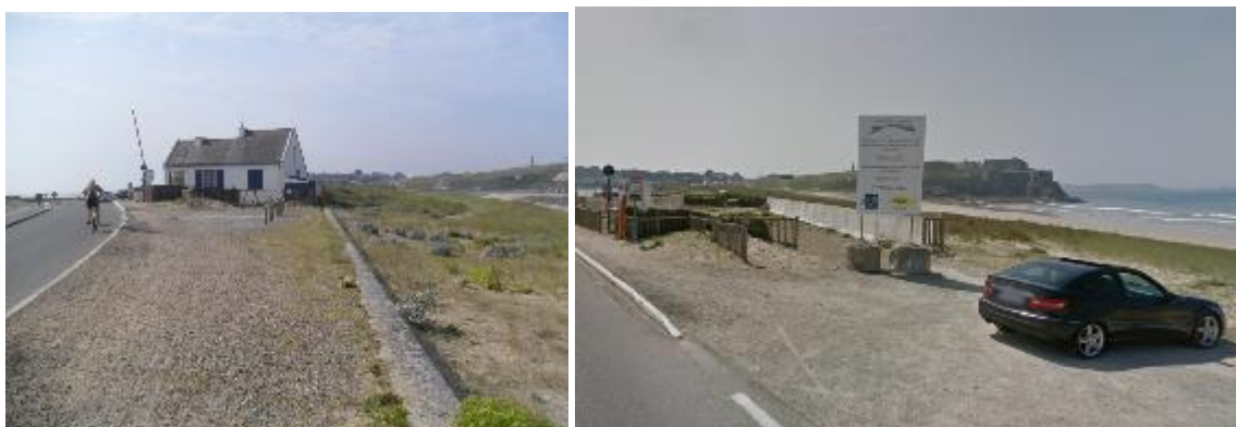
Photo 18 : Ancienne maison du garde barrière dont la démolition permet l'évitement des habitats dunaires (photo : TBM environnement)
