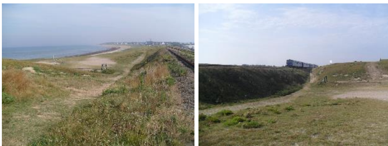
Photo 9 : Vues sur la zone 3 (photo : TBM environnement)
