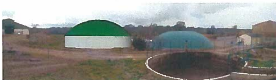
Photo-simulation : post digesteur actuel à droite et nouveau post digesteur à gauche (source : Étude d'impact)
