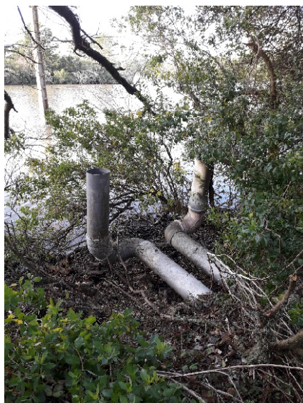
Figure 5 : ouvrage de connexion potentielle entre le fossé et le plan d'eau en rive droite
