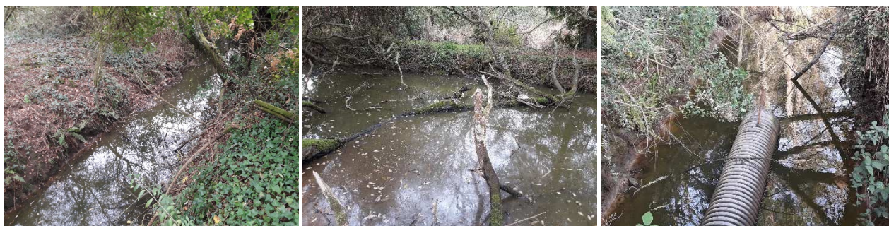
Figure 8 : de gauche à droite : cours d'eau au droit du plan d'eau en amont puis en aval – passage busé à l'entrée du plan d'eau
