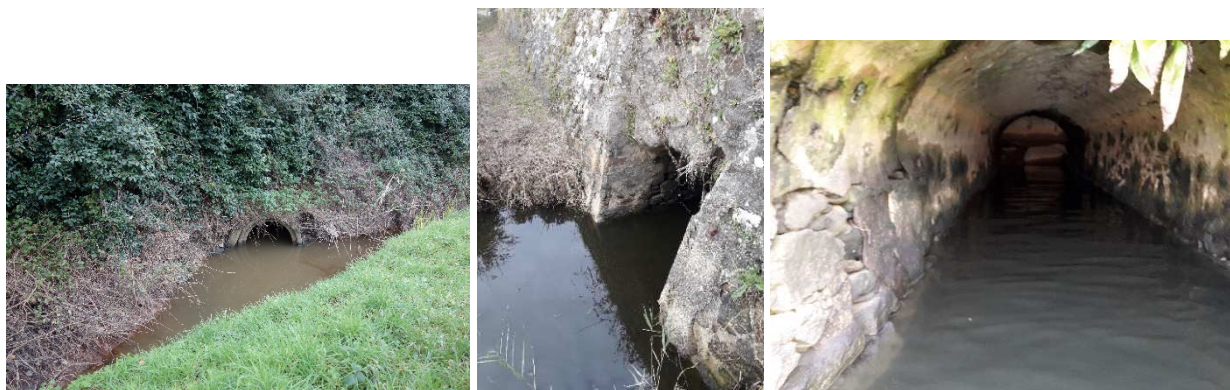
Figure 9 : de gauche à droite : entrée de la buse – sortie de l'ouvrage – vue de l'intérieur depuis l'aval
