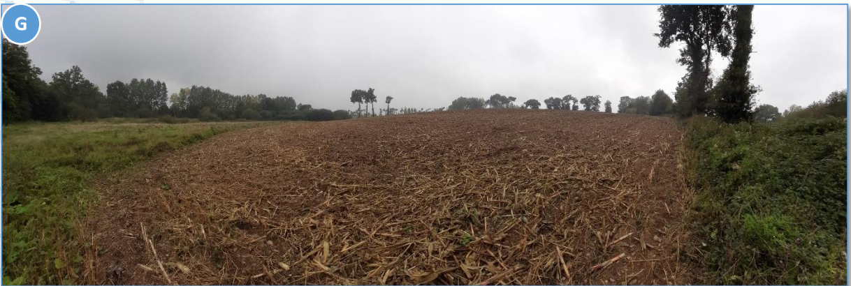
Fig. 12 : Vues sur les secteurs déjà exploités et remis en état
