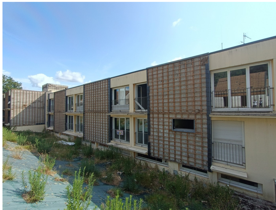
Foyer de la sapinière en cours de démolition
