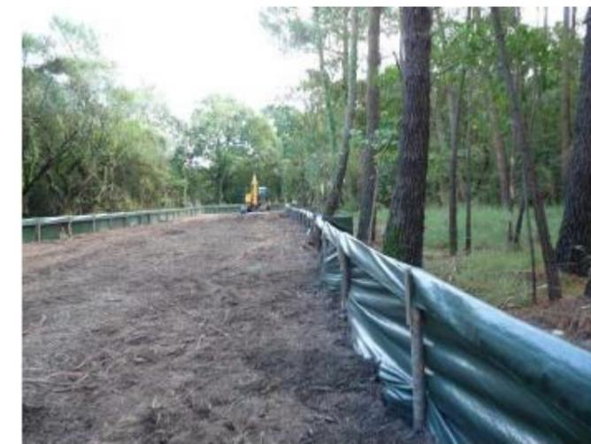
Photo 106 : Exemple de bâches posées pour éviter la traversée du chantier par les amphibiens
