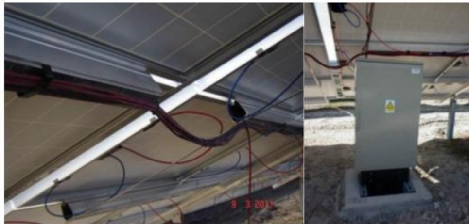
Photo 104 : Illustration du raccordement et d'une boîte de jonction
