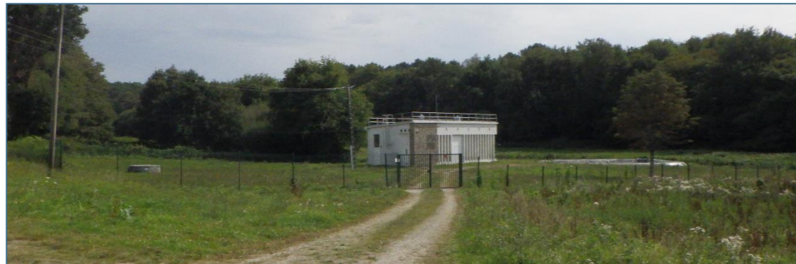
Photo 13 : Captage de Cran
